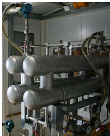
Блок одоризации в отсеке блок-бокса переключения. АГРС «Саратов-10М»
