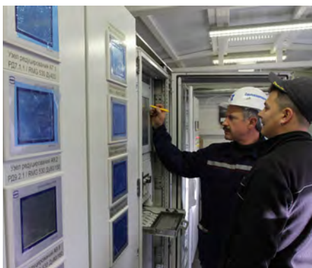
Блок-бокс КИПиА АГРС Адлерского района города Сочи. Отладка оборудования САУ ГРС
