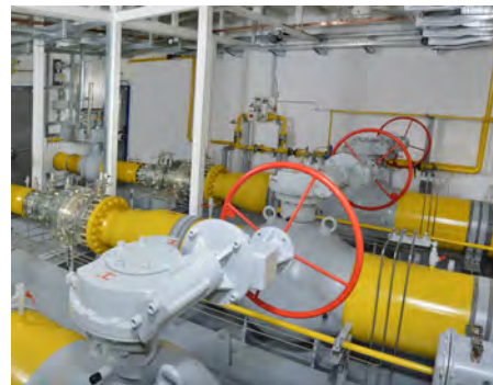
Зал редуцирования АГРС, производительностью 120 000 \text{нм}^3/\text{час}
