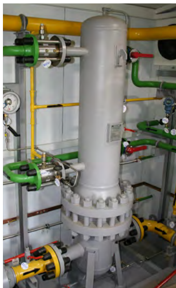
Теплообменник газовойдояной ТГВ-100/7,5
